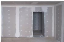
**2- Sur cloison sèche** utilisez les vis à frapper **PixANCHORS™**. Pré-percez le panneau et le support avec un foret pour métaux Ø6mm. Assurez-vous qu'il ne reste aucun copeau d'aluminium dans le trou (risque de court-circuit). Insérez la cheville plastique dans l'épaisseur du panneau et la cloison sèche pour préserver le panneau de tout court-circuit lié à la vis métallique.
